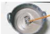
• Amasar weberfloor top con 4,5 litros de agua limpia por saco de 25 kg mediante batidor eléctrico o máquina de bombear hasta obtener una mezcla homogénea y sin grumos. Las propiedades de fluidez del producto deberán ser comprobadas mediante un ensayo de fluidez (240-250 mm de diámetro con el cono estándar Weber) antes y durante el bombeo, empleando un anillo medidor de flujo y una placa.
